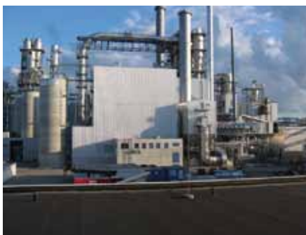
WISMAR (DE) , od 1999, výstavba 2006, tepelný výkon: 80 MW parní výkon: 101 t/h
