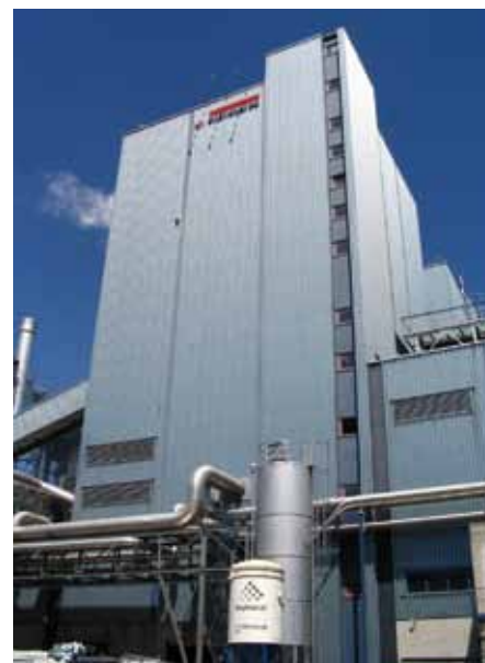
BRILON (DE) , od 1991, výstavba 1993 a 1996, tepelný výkon: 150 MW parní výkon: 165 t/h
