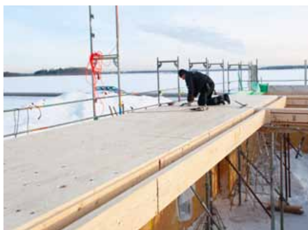
STEICO LVL X jako plošně ztužující prvek stropní konstrukce.
