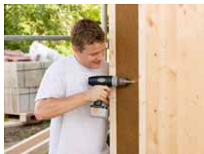
Přípevnění nosníků STEICOWall šrouby přes pásničky do masivní dřevěné stěny.
