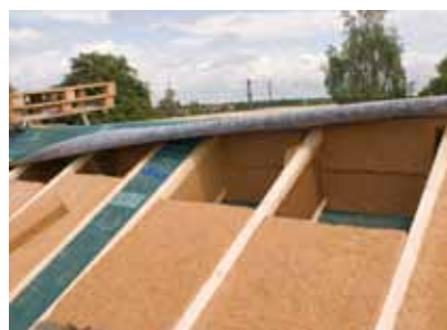
Pohled do konstrukce střechy. Nosníky s izolační stojiny a izolace STEICOflex.
