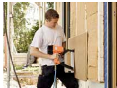
Izolace STEICOflex a fasádní deska STEICOuniversal pod obkladem z modřínových palubek.
