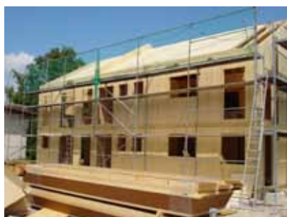
Nosníky STEICOjoist jsou připraveny pro montáž na střechu.
