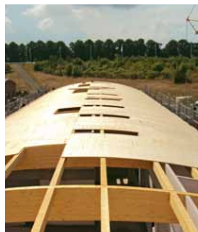
Příklad: Ztužující střešní opláštění haly o velkém rozpětí.
