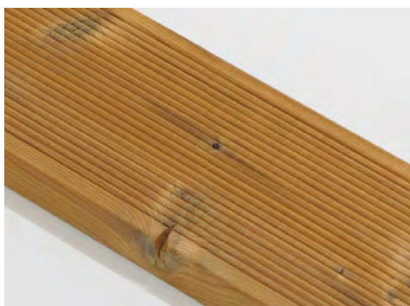
Malá prasklina suku na hraně je povolena.
