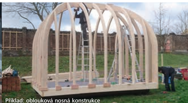
Příklad: oblouková nosná konstrukce
