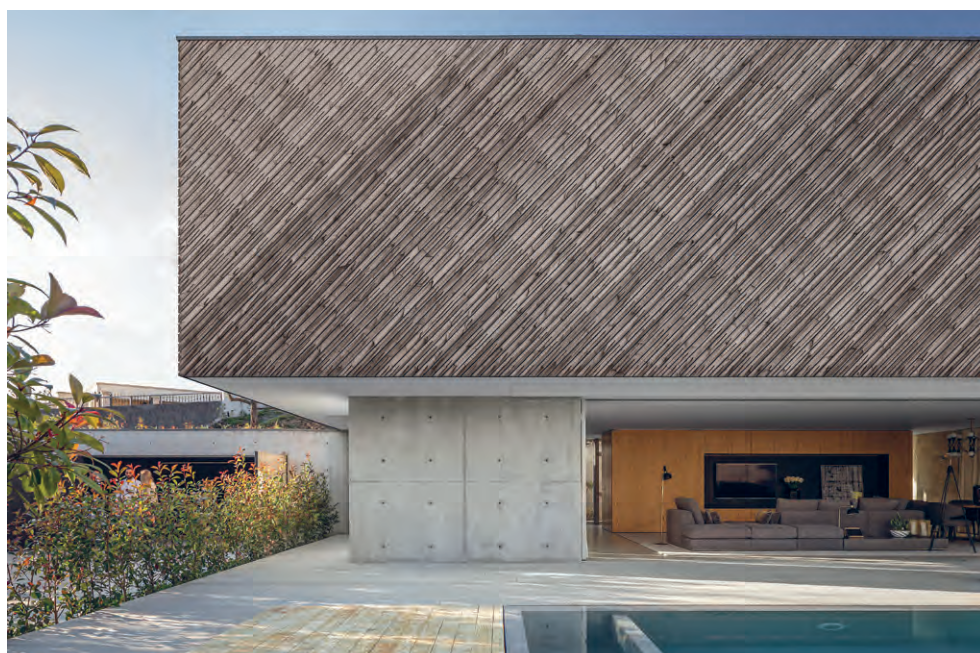
■ Dům A, Portugalsko. REM'A Arquitectos. Fotografie: Studio Ivo Tavares
