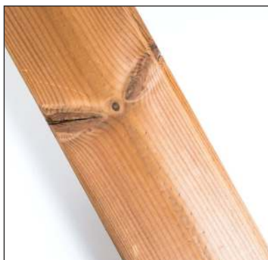
Praskliny v sucích jsou povoleny
