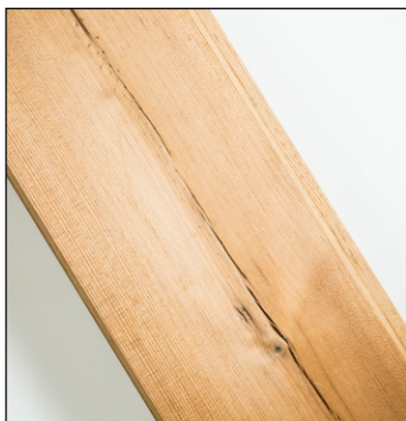
Malé praskliny na povrchu prken jsou povoleny
